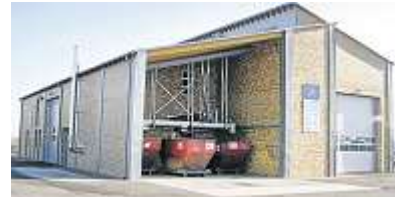
Fehlinvestition: die Klärschlamm-trocknungsanlage Foto: MZ-Archiv
